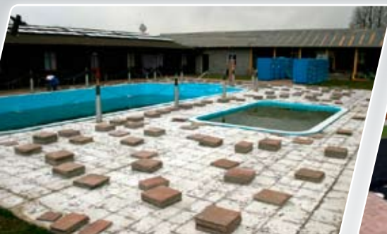
rozebrání původních, odlepených dlaždic kolem bazénu
