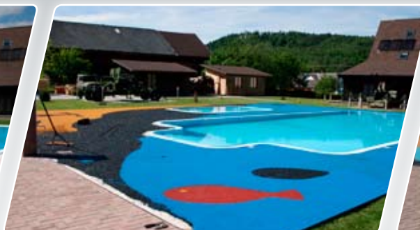
pokládka vrchní barevné vrstvy EPDM vč. grafiky
